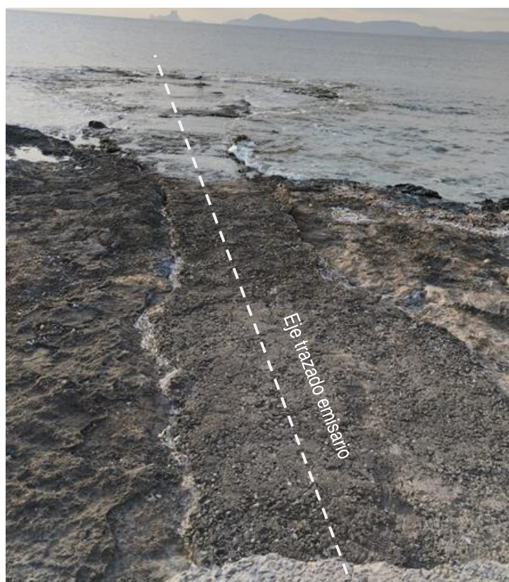
Imagen 21 Prof = 0 m. Transición entre tramo terrestre y tramo marino del emisario actual. Se observa la protección de hormigón y el entorno completamente de naturaleza rocosa.
